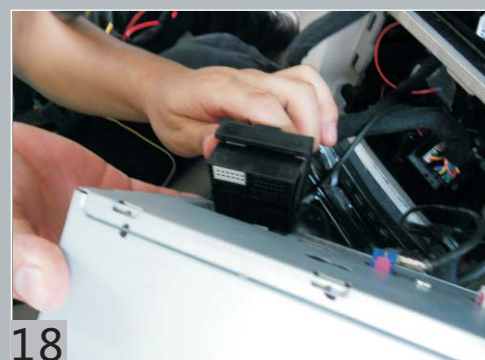
Подсоедините остальную проводку к новому головному устройству и установите его на место как показано на фото.
